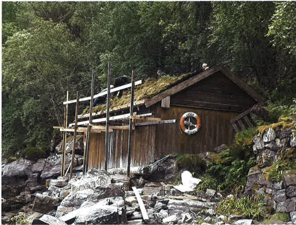
Arbeid på naustet, Ytste Skotet
